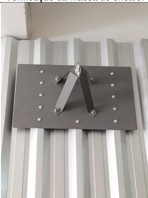
Dispositivo de ancoragem antes do ensaio.
